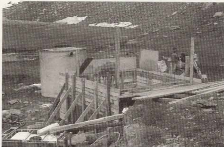
Armatura di supporto e protezione attorno alla fossa biologica I.M.O.F.
